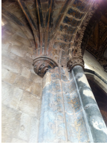
FIGURA 4 Capela dos Carneiros – arranque da abóbada
